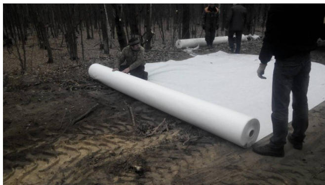
Рис. 2 Раскатка геосинтетического материала
